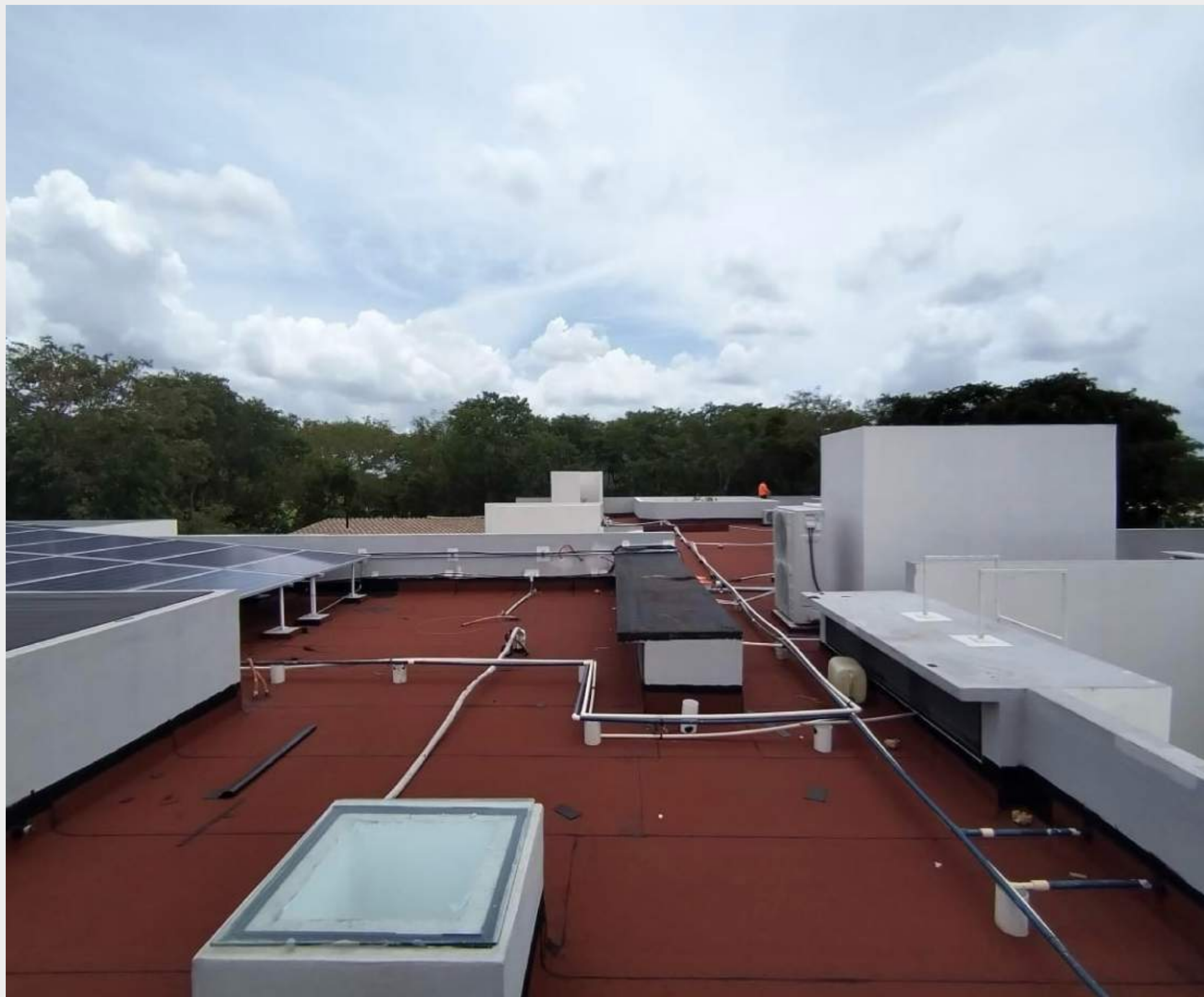
Sistema impermeabilizante prefabricado en casa habitación.
