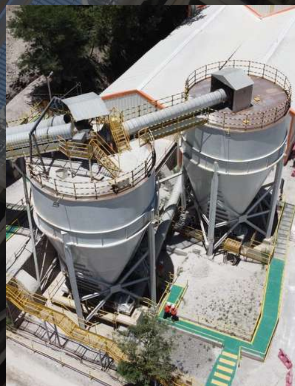
Levantamiento Inspección de estado actual
