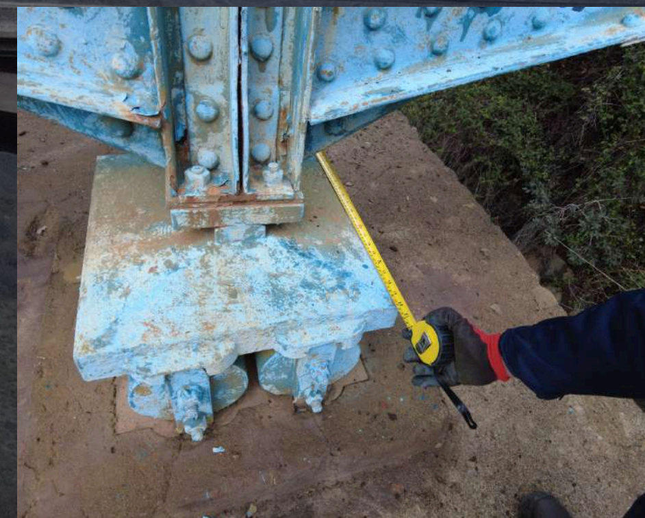
Levantamiento Medición de elementos estructurales
