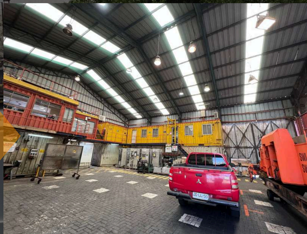
Levantamiento Inspección de estado actual
