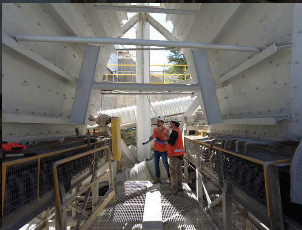
Levantamiento Medición de elementos estructurales
