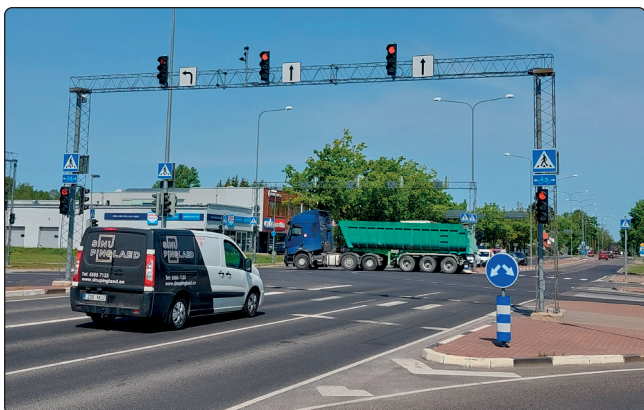
Asula ristmikul sõidurajade suundi tähistavad märgid. Ristmiku võib läbida otse (kaks sõidurada) ja teha vasak- või tagasipööre.
