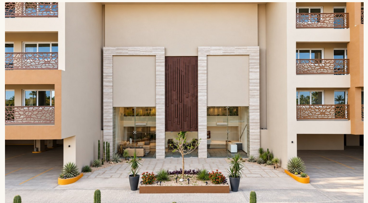
Fachada principal y acceso al lobby
