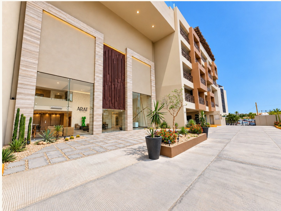
Acceso exterior de ARAT Los Cabos
