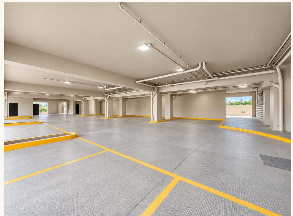
Estacionamiento techado del edificio
