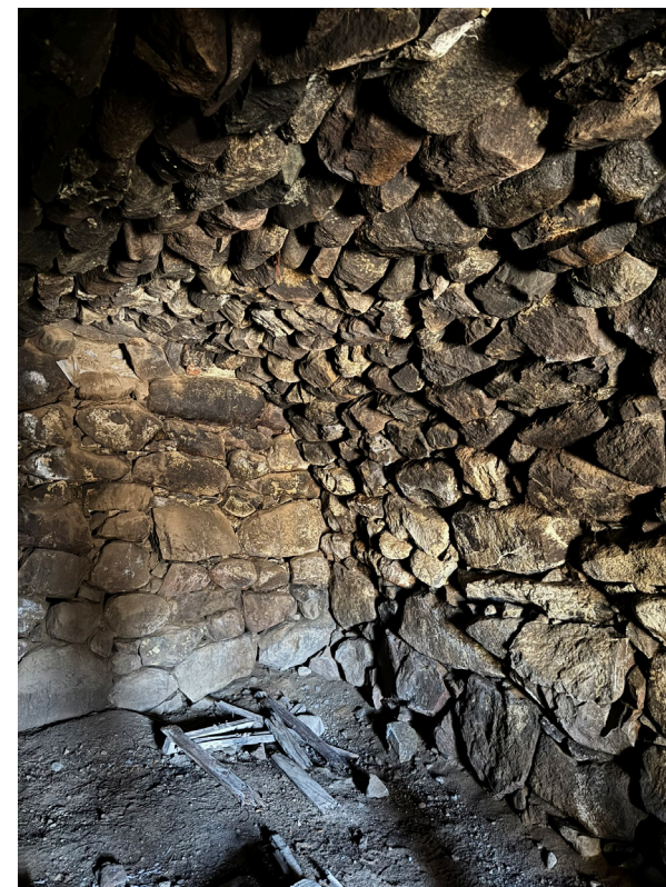
Innsiden av jordkjelleren med det typiske steinhvelvet. Naturstein i slike kjellere sikrer god magasinering av varme
