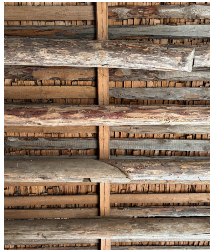
På innsiden av bygningene kommer spontaket til syne.
